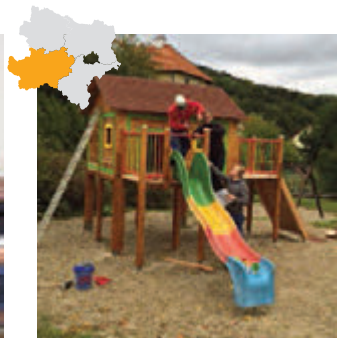
Hofamt Priel Es wurde ein Kletterhaus am Spielplatz errichtet. Eine mobile Gemeindehütte wurde für gemeinnützige Zwecke erschaffen.
