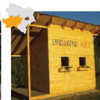
Rust Eine neue Beachvolleyballhütte wurde errichtet.
