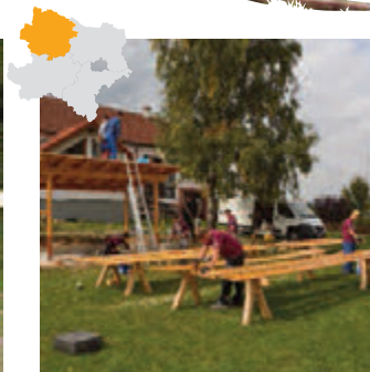
Jahrings Als Windschutz wurde eine Mintribüne am Sportplatz gebaut.
