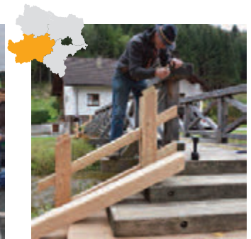
Kleinzell Die Landjugend stellte die Holzbrücke fertig.
